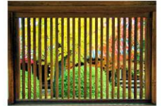
法隆寺回廊の連子窓
